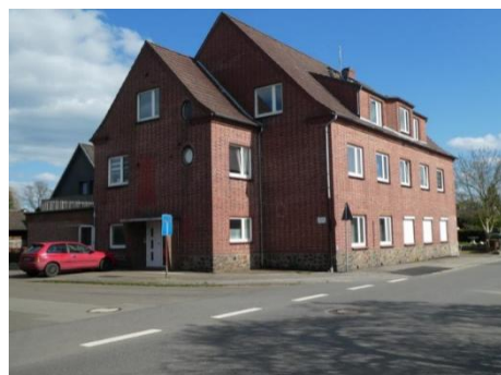
Mehrfamilienhaus (eh. Gaststätte)
