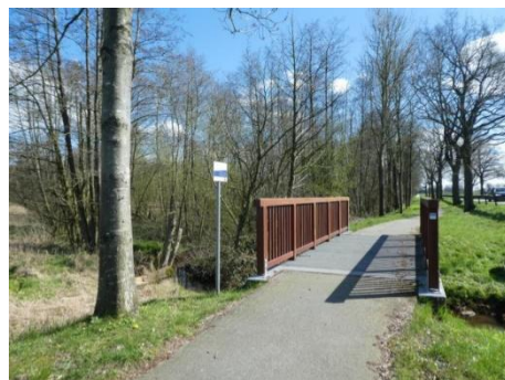
Radwegbrücke über die Krückau, Blick auf den Römer
